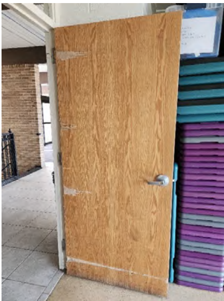
21. Damaged door slab
