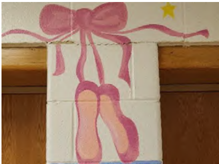
29. CMU cracking at hallway door alcoves
